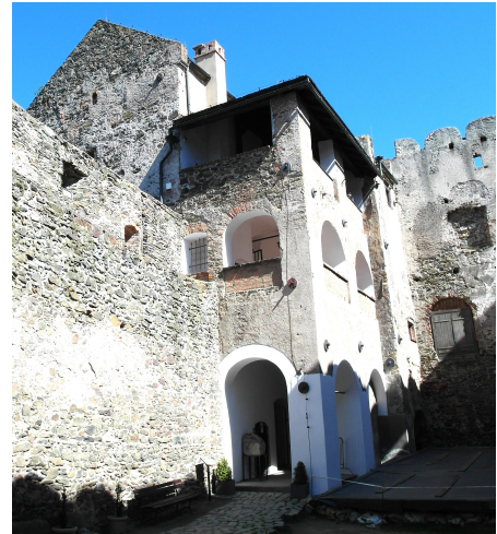
Fot. 3. Dom Niewiast (fot. J. Milewski)
