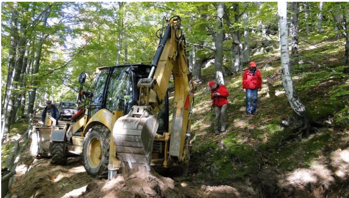
Prace budowlane przy nowej drodze. Foto: Krzysztof Tęcza
